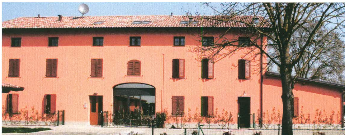
Foto post intervento
